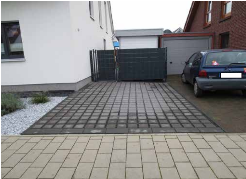
Stellplatz: Pflaster mit durchlässigen Fugen → „stark versiegelt“
